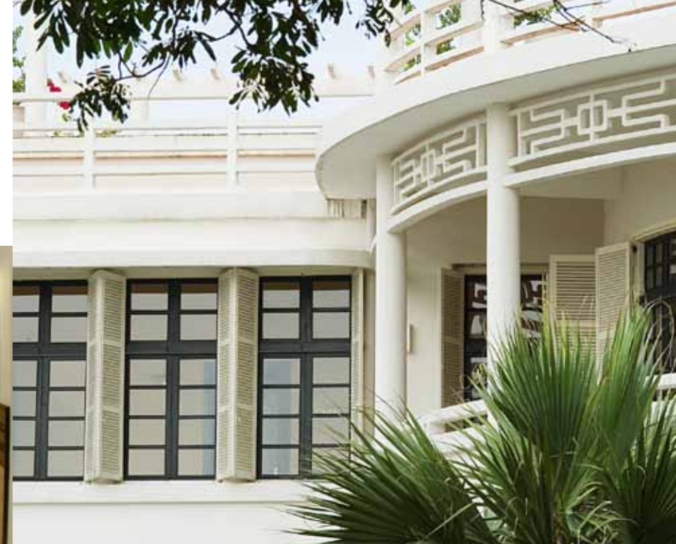
Un dettaglio della facciata. | A façade detail.
